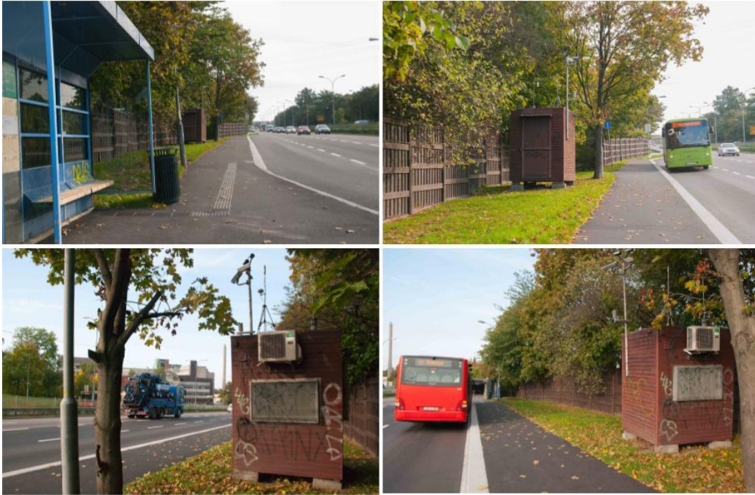
Figur 50: Situasjonsbilder RV4 Aker sykehus, Oslo. Mot øst-nordøst (ø. v.), øst (ø. h.), vest-sørvest (n. v) og vest (n. h.).
