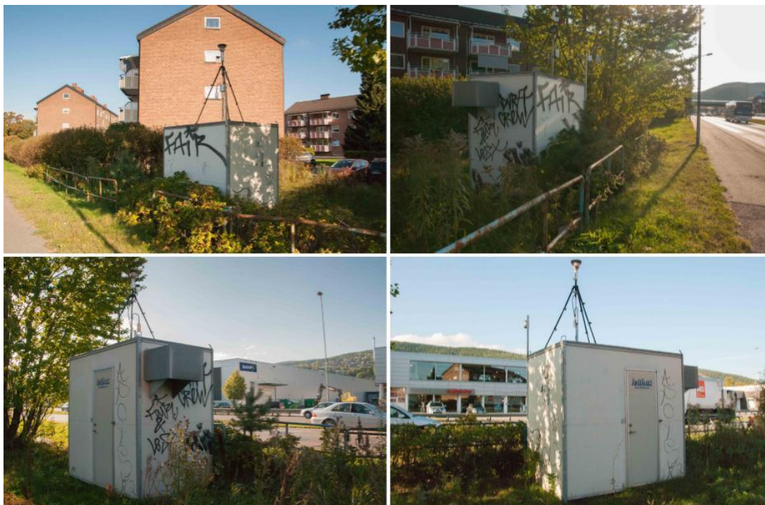
Figur 65: Situasjonsbilder Bangeløkka, Drammen. Mot nord (ø. v.), øst (ø. h.), sør (n. v) og vest (n. h.).
