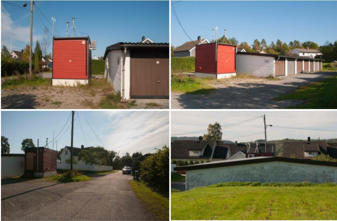
Figur 82: Situasjonbilder Øyekast, Porsgrunn. Mot nord-nordøst (ø. v.), øst (ø. h.), sør (n. v) og vest (n. h.).
