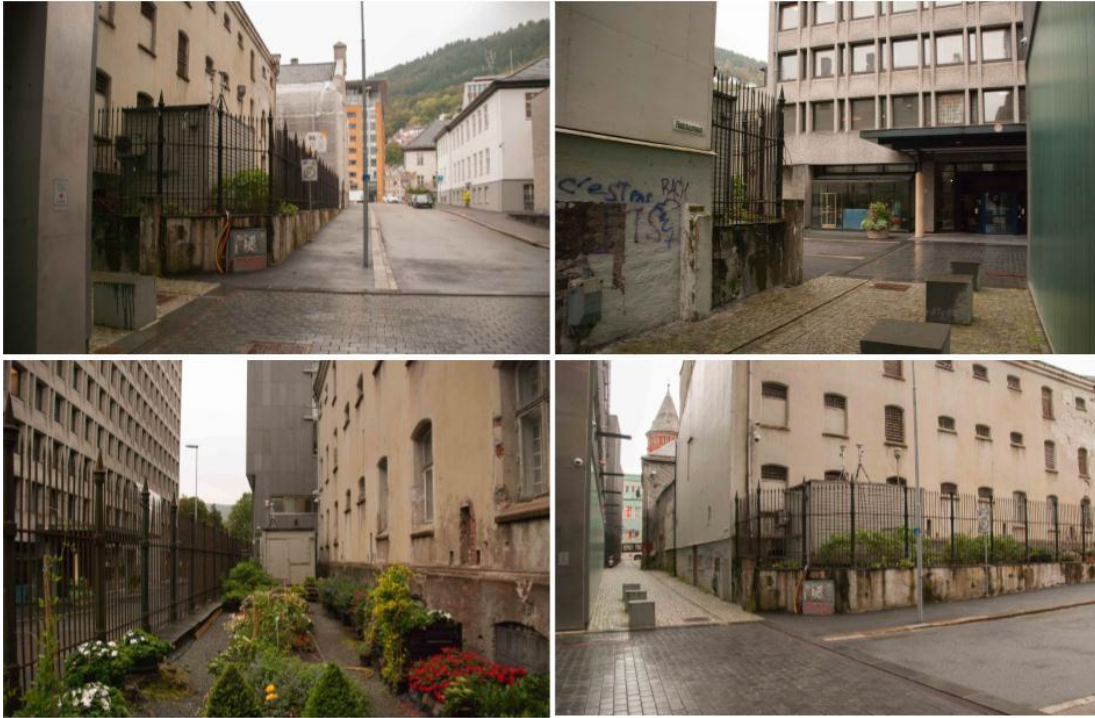
Figur 33: Situasjonsbilder Rådhuset, Bergen. Mot nord-nordøst (ø. v.), øst (ø. h.), sør-sørvest (n. v) og vest-nordvest (n. h.).
