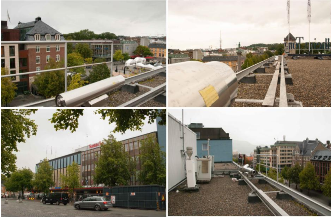
Figur 18: Situasjonsbilder Torvet, Trondheim. Mot øst-nordøst (ø. v.), øst (ø. h.), sørøst fra gatenivå (n. v) og vest-nordvest (n. h.).
