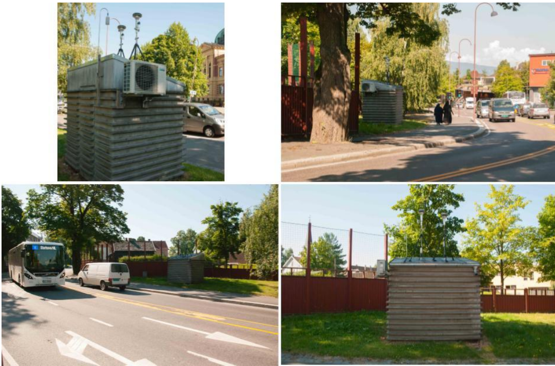
Figur 28: Situasjonsbilder Bankplassen, Lillehammer. Mot nord (ø. v.), nordvest (ø. h.), sør (n. v) og sørvest (n. h.).
