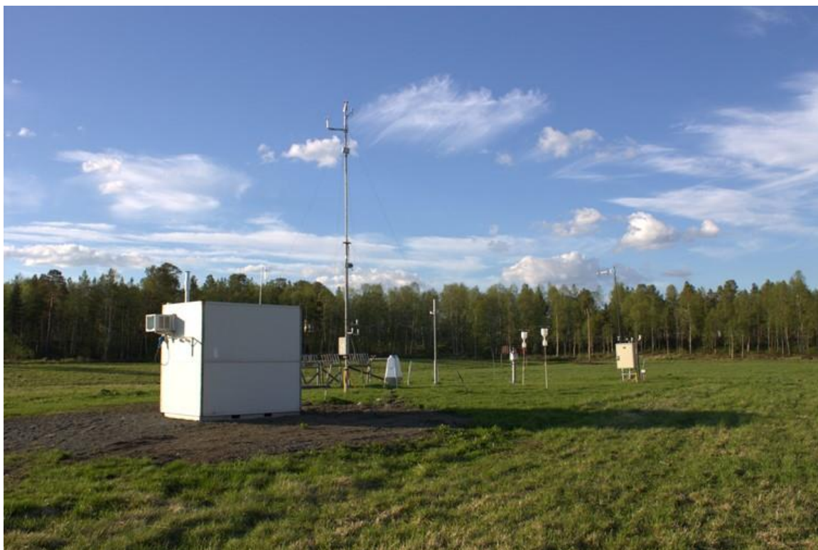
Bilde 3: NILUs målestasjon på Svanvik. Den ligger ute på jordet ved Svanhovd miljøsenter (NIBIO). Merk inntak for støvmålinger på taket til venstre og inntak for SO 2 -målinger på taket til høyre (svanehals). Masten har meteorologiinstrumenter i 10 m høyde. To nedbørprøvetakere til høyre tar prøver for tungmetaller. Instrumentet helt til høyre tilhører NVE. Stativet med metallplater i bakgrunnen er en del av et europeisk korrosjonsprosjekt (Grøntoft og Ferm, 2014). Strålevernets instrumenter er skjult bak måleboden.
