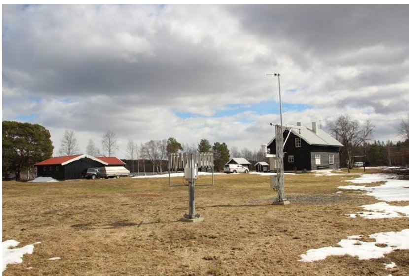
Figur 6: Målestasjonen på Nyrud øverst i Pasvikdalen, om lag 65 km sør for Svanvik og 4 km sør for Noatun. Nedbørsamler til venstre, masten til høyre har temperaturmåler og måler for snødybde. Stasjonen driftes av Meteorologisk institutt. Bak sees Nyrud gård som nå er politistasjon, Pasvikelva skimtes bak bjørketrærne og også øya Vaarlamasari på russisk side. Bildet er tatt 27. mai 2017. Foto: Benjamin Flatlandsmo Berglen.
