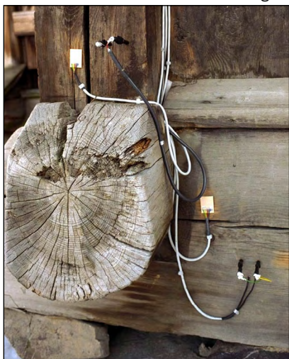
Måling av fukt med WetCorr-instrumentet på Maihaugen i Lillehammer.
