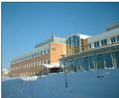
I 1994 flyttet NILU inn i nybygget på Kjeller.
