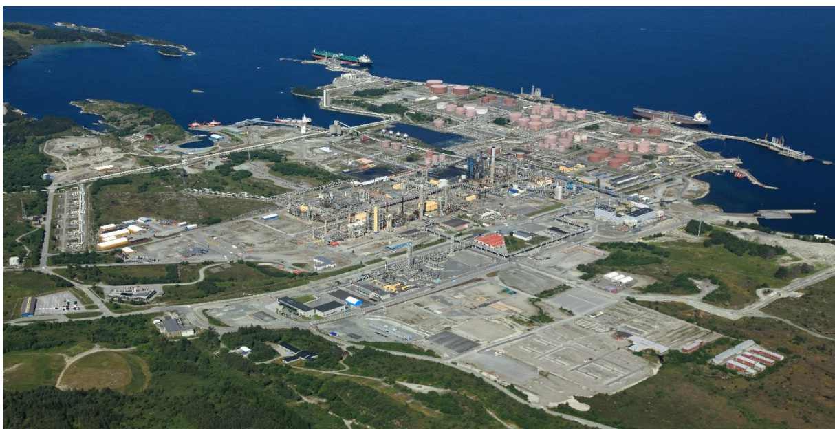
Figur 1: Industriområdet til Mongstad raffineri og omgivelsene. Selve raffineridelen sees midt i bildet med tankfarmen og utskipingshavn mot sjøen lengst mot nord. Kilde: Equinor.
