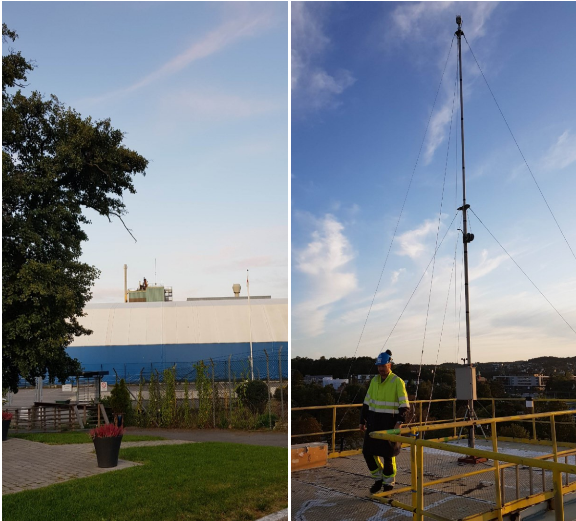
Figur 4: Meteorologisk mast på taket av bygget som huser koksovnene, rett ved faklene fra kalsineringsovnene. Masten er midt i venstre bilde. Foto: Even Kristian Teigland.
