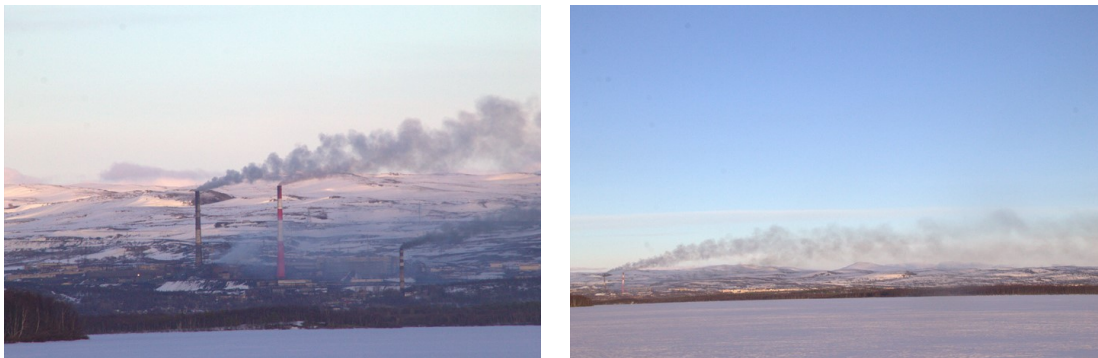
Bilde 1: Røyken fra smelteverket i Nikel sett fra isen på Pasvikelva ved Utnes. Bildene er tatt 18. april 2016 om kvelden. Til venstre vises nærbilde av utslippene, mens høyre bilde viser hvordan den svarte røyken stiger opp til et visst nivå og bringes så horisontalt sørover. Røykfanen kan sees som en svart stripe på himmelen flere mil avgårde. Legg også merke til de diffuse utslippene, samt røyken fra skorsteinen til varmekraftverket i Nikel (til høyre nedenfor verket). Foto: Benjamin Flatlandsmo Berglen.
