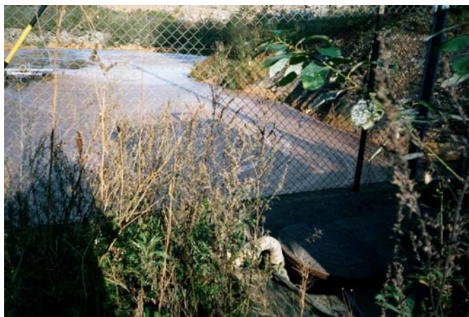
Fotos fra Grønmo: Fangdam A til venstre, Fangdam B til høyre
