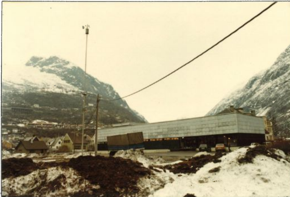
Figur 5: Masten for måling av vindretning og styrke. Bildet er tatt fra SV.
