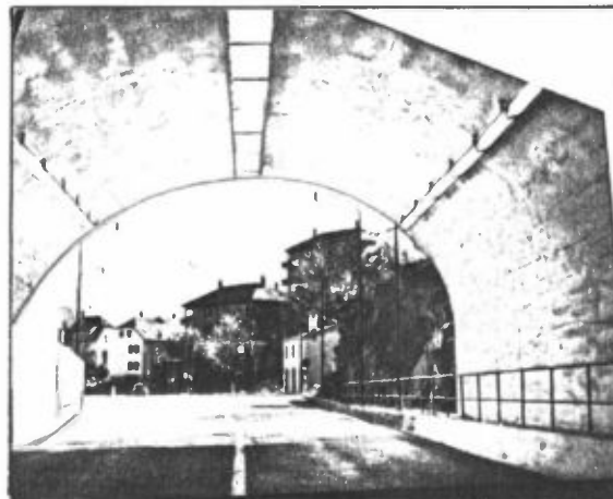
Figur 2: Eidsvågtunnelen, mot S.
