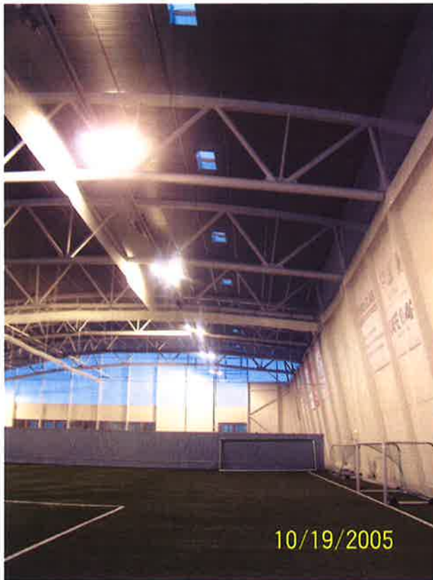
Manglerudhallen med lufteluker i taket
