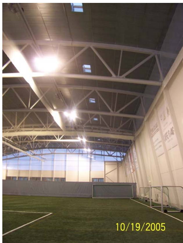
Manglerudhallen med lufteluker i taket
