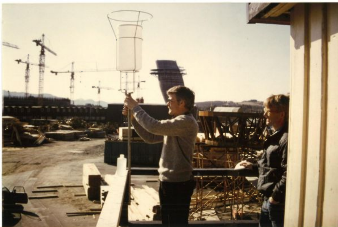
Figur 5: Stasjon 4; på anleggsområdet, med utsikt mot sandblåse-verksted.
