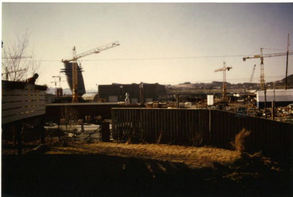
Figur 2: Stasjon 1; Hinnavågen 58, med utsikt mot anleggsområdet.
