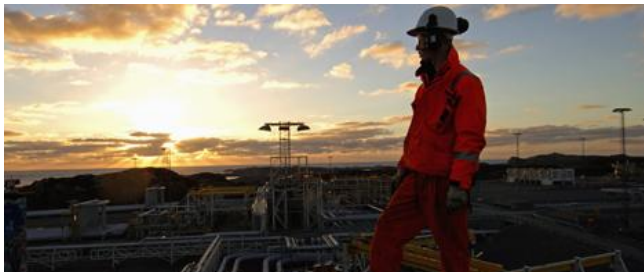
Figur 2: Bilde fra Kollsnes prosessanlegg. Kilde: Kollsnes-anleggets hjemmeside.
