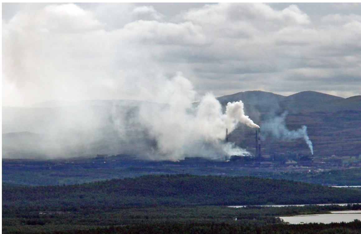
Figur 3: Smelteverket i Nikel og utslipp sett fra Brannfjellet i Pasvikdalen. Bildet er tatt 23. juli 2007, dvs. etter den såkalte sommerepisoden i 2007. Sørlig vind bringer utslippene nordover og vekk fra selve Nikel by. Merk de diffuse utslippene fra bygningene. Foto: Espen Tangen Arnes, Bioforsk Jord og Miljø, Svanhovd.
