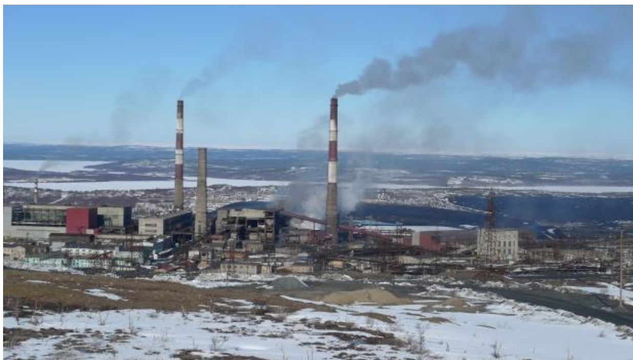
Figur 1: Smelteverket i Nikel sett østfra med Norge i bakgrunnen. Smelteverket ligger nord for selve byen. Det er utslipp både fra de tre pipene og fra smeltehallen/bygningene, såkalte diffuse utslipp. Den lave pipen helt til venstre i bildet er varmekraftverket som forsyner Nikel by. Kilde: Thomas Nilsen, BarentsObserver.
