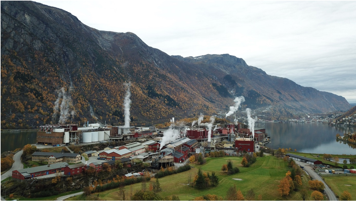
Figur 1-2 Anlegget til Boliden Odda AS på Eitrheimsneset sett fra nord-vest. Foto: Agnar Målsnes
