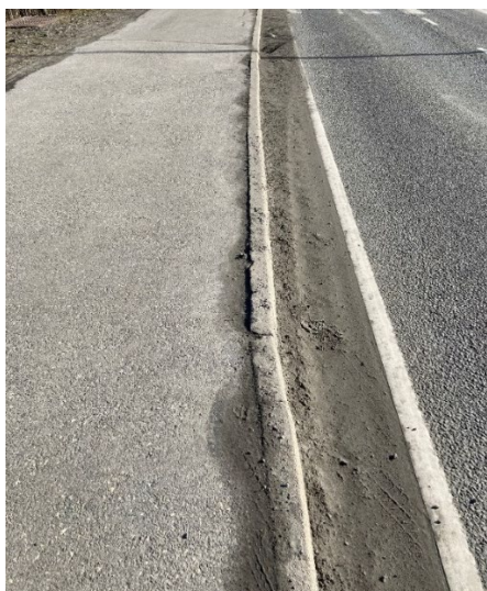
Figur C 5: Støvdepot i Fanavegen som kan ha sitt opphav i anleggsvirksomhet. Foto: Torleif Weydahl
