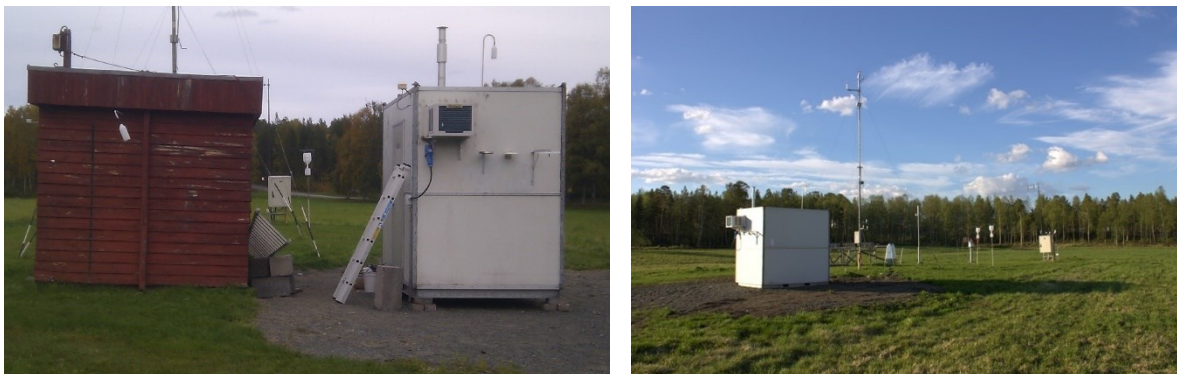
Figur 8: NILUs målestasjon på Svanvik, gammel målebod (venstre) og den nye som ble installert i 2012 (høyre). Stasjonen ligger ute på jordet ved NIBIO Svanhovd. På den nye boden; merk inntak for støvmålinger på taket til venstre og inntak for SO 2 -målinger på taket til høyre (svanehals). Masten har meteorologiinstrumenter i 10 m høyde. To nedbørprøvetakere til høyre tar prøver for tungmetaller og uorganiske komponenter. Instrumentet helt til høyre tilhører NVE. Stativet med metallplater i bakgrunnen er en del av et europeisk korrosjonsprosjekt (Grøntoft, 2016). Strålevernets instrumenter er skjult bak måleboden.
