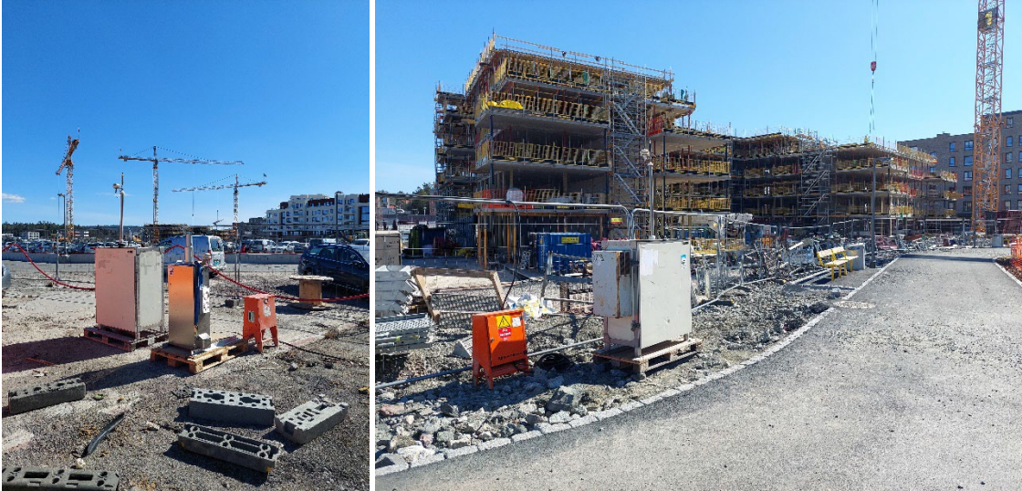
Figur 3: (Venstre) Målestasjon Skårerbyen Nord, se også Figur 4, retning mot sørøst og anleggsplassen Skårerbyen Gårdskvartalet. (Høyre) Målestasjon Skårerbyen Sør, retning mot sørøst og Skårerbyen Pluss hus.
