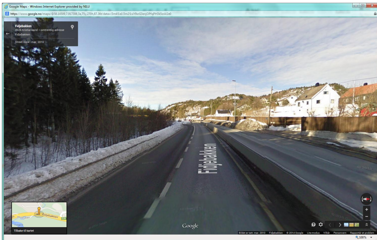
Figur 7: Vegen vestover med støyskjerm og bruksnummer 179 i høyre del av bildet.
