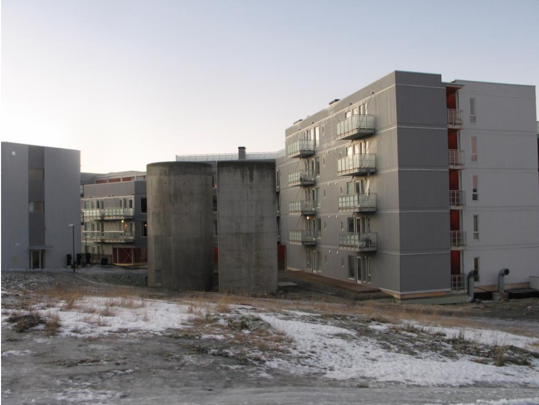
Figur 3: Ventilasjonstårn på Tomasjordnes.
