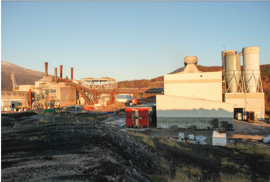
Figur 1: Finn fjord AS, sett fra silicadeponiet der vindmålingene ble utført. Smelteovnene befinner seg i bygget til venstre, bygget til høyre er filterhuset. Utslippet fra filterhuset skjer gjennom spalter på taket.
