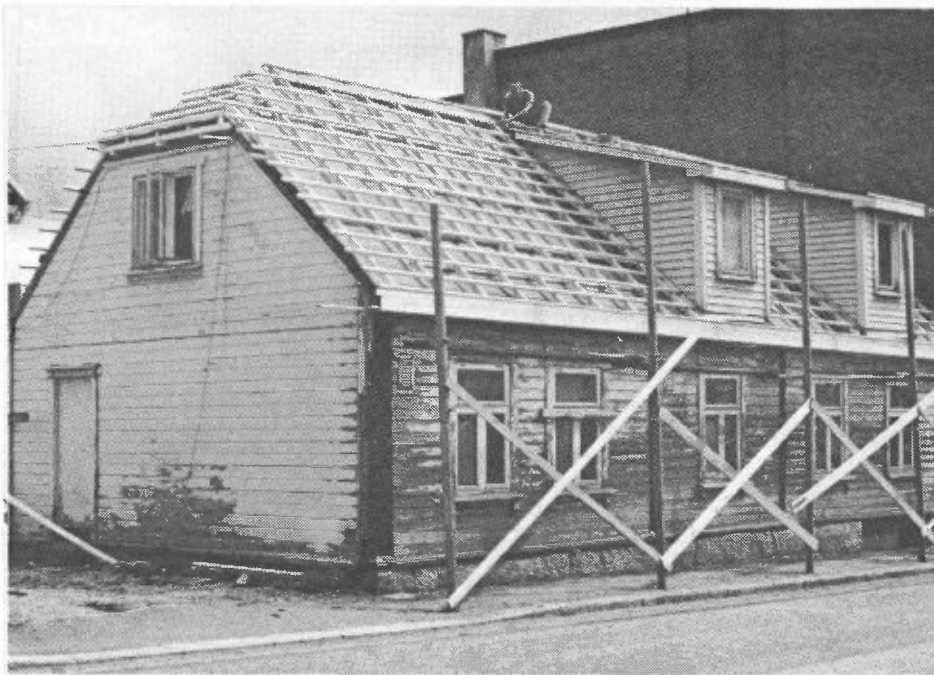
Foto nr. 13: Ombygging av et gammelt hus fra 1840-årene.
