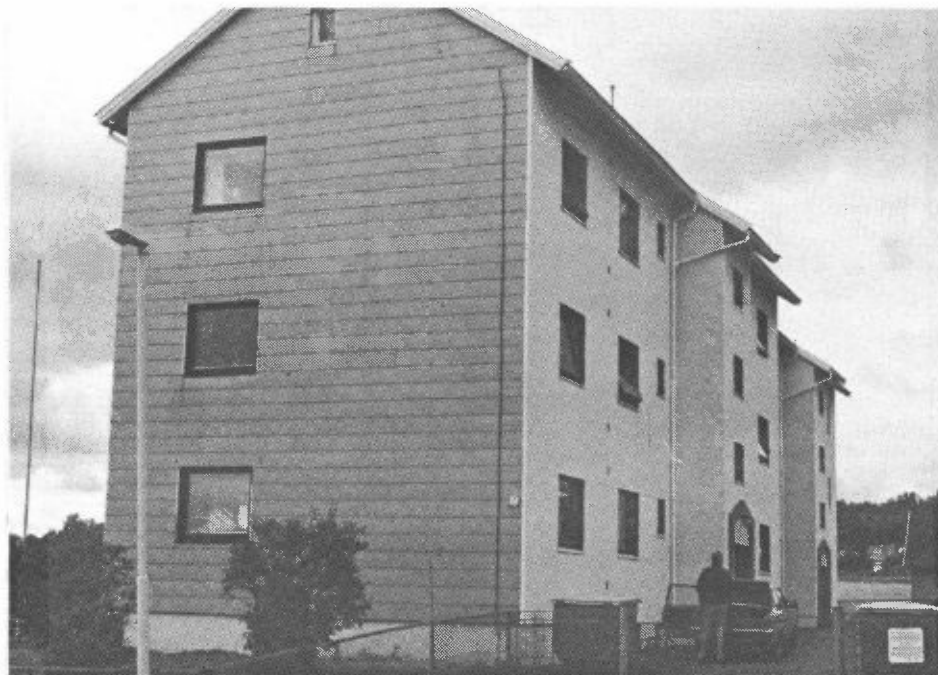
Foto nr. 12: Eksempel på en flerbolig som er etterisolert og kledd med "Steni"-plater og eternitt.
