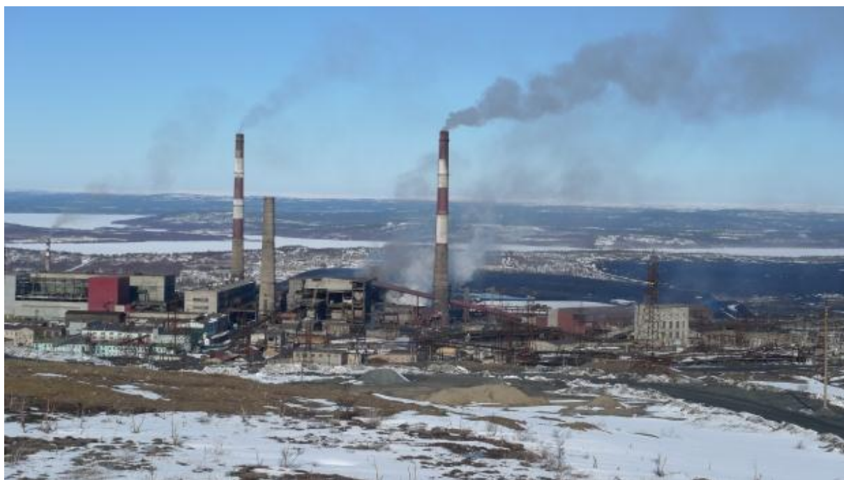
Figur 1: Smelteverket i Nikel sett østfra med Norge i bakgrunnen. Smelteverket ligger nord for selve byen. Det er utlipp både fra de tre pipene og fra smeltehallen/bygningene, såkalte diffuse utlipp. Den lave pipen helt til venstre i bildet er varmekraftverket som forsyner Nikel by. Kilde: Thomas Nilsen, BarentsObserver.
