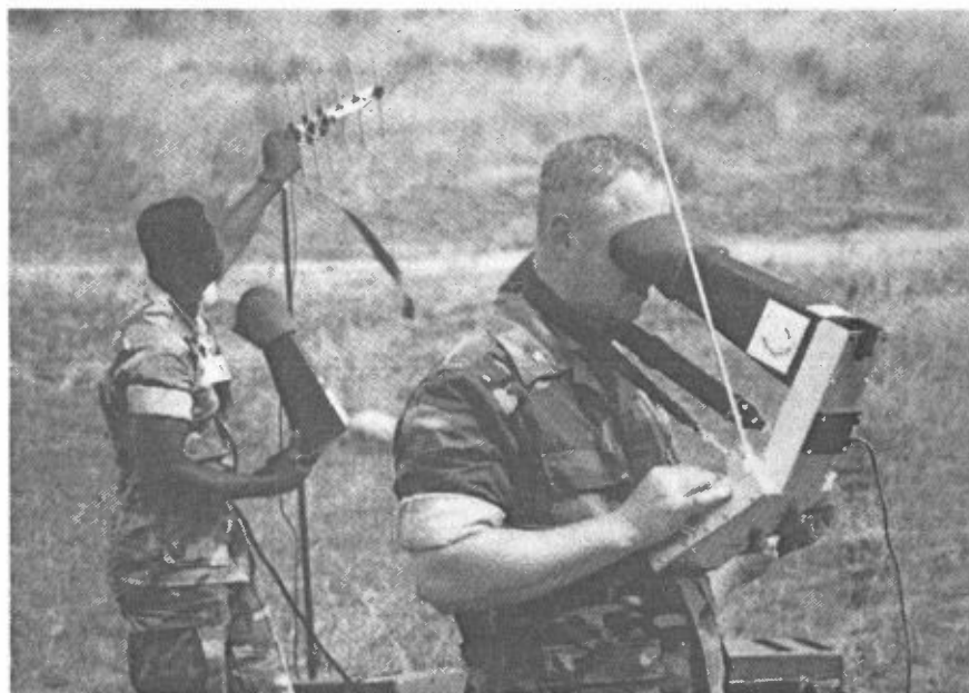
Figur 9: Bildet viser en pilot og en hjelpemann. Piloten styrer flyet ved hjelp av et TV-bilde, hjelpemannen retter antennen til enhver tid mot flyet.
