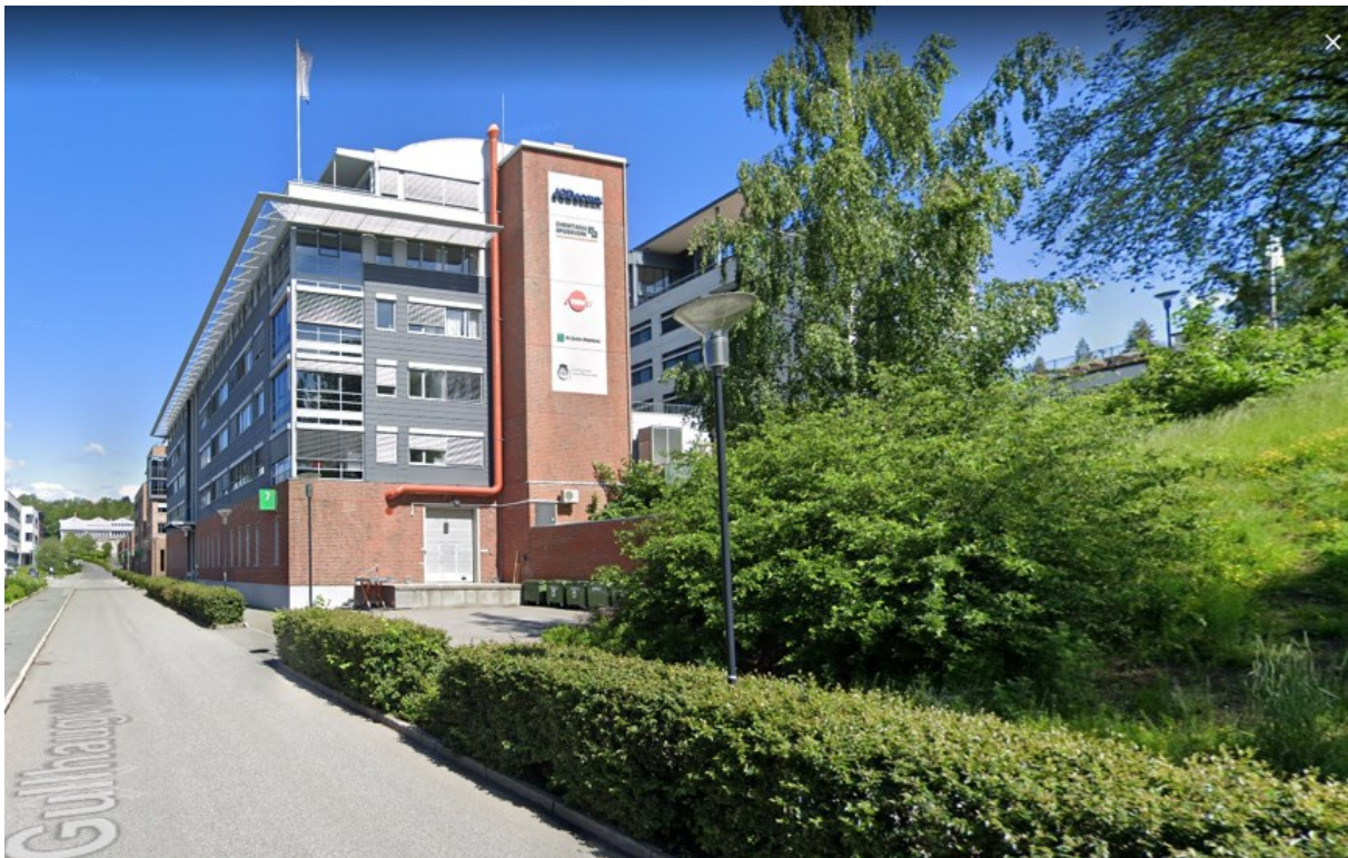
Figur 2: Oncoinvent sitt lokale i Gullhaugsveien 7 i Nydalen. Utslippet ledes gjennom røret, som kommer ut fra laboratedelen i grunnetasjen og ledes opp langs veggen, og slippes så ut på taket. Merk takterrassen med delvis tak til venstre. Også utløpet for det generelle ventilasjonsanlegget kan sees nede til høyre på bygget.
